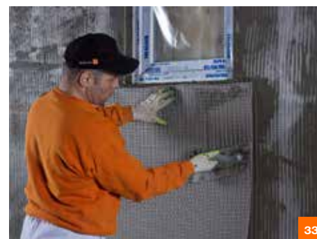
На участках под камень или плитку работы ведутся с применением клеебазовых составов SKS/RAS и сеток PUG/PGP .
