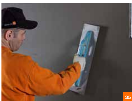
По истечении технологического перерыва на высыхание армированного базового слоя (из расчёта 24 часа на 1 мм толщины слоя, при температуре наружного воздуха не менее 15 С°) приступаем к нанесению декоративно-защитных слоев.
