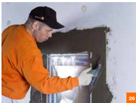
На основной плоскости снимаем излишки раствора «на сдир»
