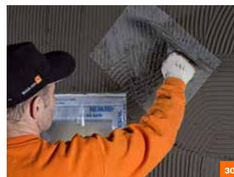
«Косынки» устанавливать под углом 45°.
