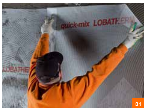
Уложить и слегка придавить шпателем в свежеложенный раствор армирующую сетку GWS с нахлестом полотен не менее 100 мм.
