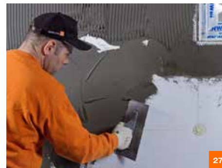
Для начала устройства армированного базового слоя на плоскости стен наносим зубчатым шпателем (зуб 8x8мм) штукатурный раствор на поверхность плит утеплителя.
