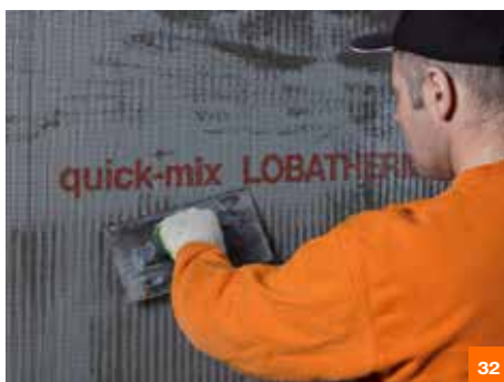
Втапливать с усилием сетку в слой базового штукатурного раствора недопустимо.
