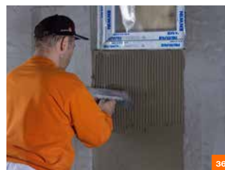
Для приклейки плитки или камня на предварительно обработанный грунтовкой UG армированный базовый слой SKS/RAS зубчатым шпателем (зуб 8 мм) нанести клеевой раствор RKS .
