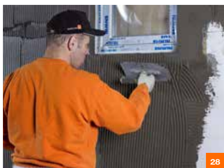
При нанесении выдерживать угол в ~60° между шпателем и поверхностью утеплителя для обеспечения толщины штукатурного слоя в 4-5 мм;
