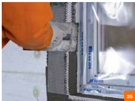
Завершаем устройство армированного базового слоя в откосах, укрывая профильные элементы штукатурным раствором KAS/SKS .
