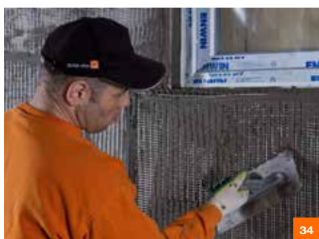
Поверх армирующей сетки «свежее по свежему» наносим второй – финишный – слой штукатурного раствора KAS/SKS толщиной 1-2 мм, полностью укрывая текстуру сетки и формируя ровную поверхность. Общая толщина армированного базового слоя под декоративную штукатурку должна быть около 4 мм. Толщина базового слоя SKS/RAS под плитку или камень – 7 мм.
