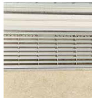
Деформационный шов между дренажным желобом и покрытием. С помощью посыпки поверхности кварцевым песком можно придать ей необходимые цвет и структуру.
