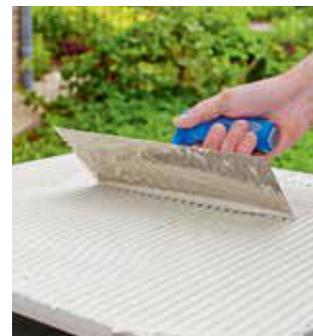
Для оптимального сцепления между керамическим элементом и раствором для подстилающего слоя на плитку зубчатым шпателем с шириной зуба 6 мм наносят раствор-шlam для повышения адгезии, например, трассовый раствор-шlam TNH-flex от tubag
