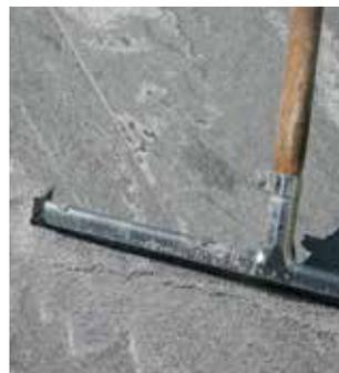
Раствор для заполнения швов брусчатki tubag PFK зашlamовывают как и обычный песок для заполнения швов с большим количеством воды. Благодаря мелкой зернистости песка можно заполнять швы шириной от 2 мм.
