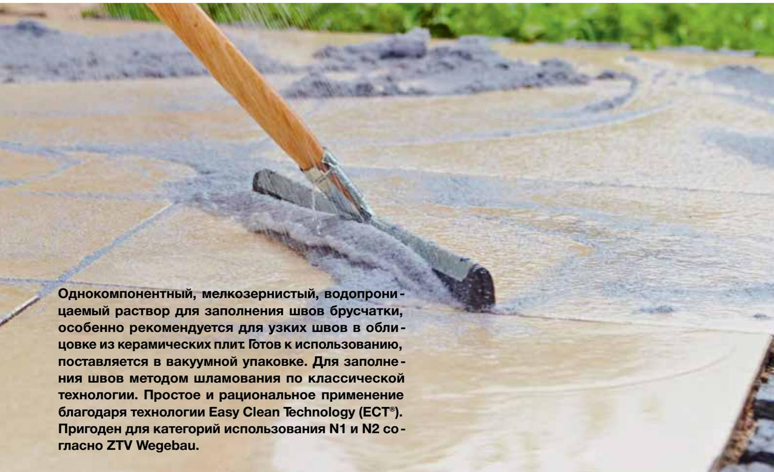
Однокомпонентный, мелкозернистый, водопроницаемый раствор для заполнения швов брусчатки, особенно рекомендуется для узких швов в облицовке из керамических плит. Готов к использованию, поставляется в вакуумной упаковке. Для заполнения швов методом шламования по классической технологии. Простое и рациональное применение благодаря технологии Easy Clean Technology (ECT®). Пригоден для категорий использования N1 и N2 согласно ZTV Wegebau.
