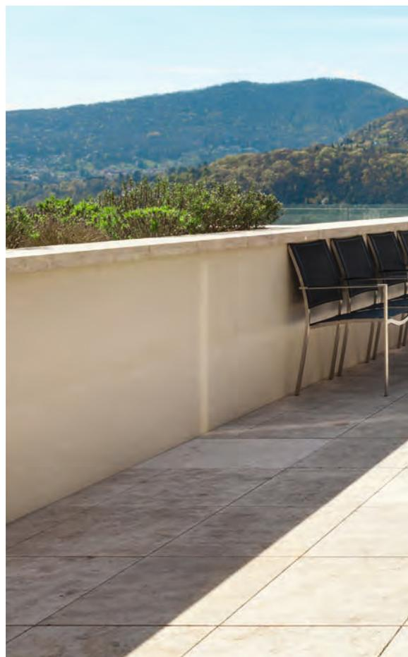
Плиты из керамогранита — это именно тот материал, который позволит Вам создать долговечные покрытия с превосходным внешним видом. Такие плиты часто имеют большие размеры при относительно малой толщине (~ 2 см). Однако нормативная документация по укладке керамогранита на открытом воздухе до сих пор отсутствует. При укладке на песок или щебень плитки могут смещаться на подстилающем слое. В резуль-
