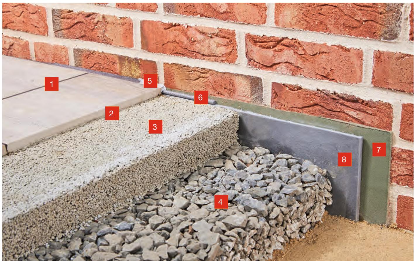
Ни одно строительное сооружение не может быть полностью свободным от напряжений. Это также относится к дорожкам и другим поверхностям с покрытиями в садово-ландшафтного строительстве. Поэтому большие взаимосвязанные области необходимо разделять с помощью деформационных швов. Таким образом можно значительно снизить риск образования трещин. Однако стоит учитывать, что деформационные швы являются слабым местом в системе. На практике хорошо
