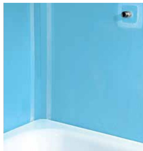
3. DA – Гидроизоляция стен и пола
