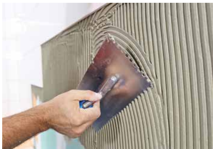
4. FX 900 – Укладка плитки
