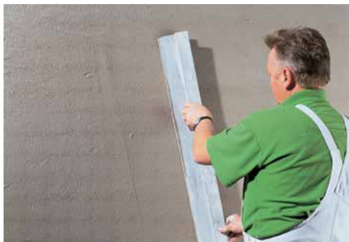
1. МК 3h – Оштукатуривание стен
