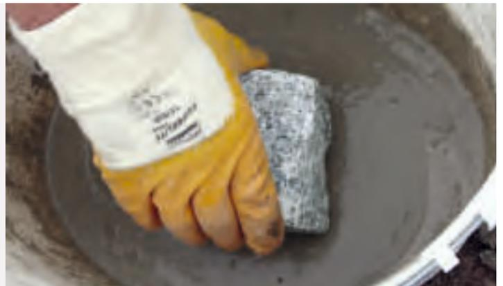
Раствор-шлам для повышения адгезии TNH-flex от tubag наносится непосредственно перед укладкой на нижнюю сторону камня или плиты. Для определенных конструкций раствор-шлам может быть нанесен на подстилающий слой распылением.
