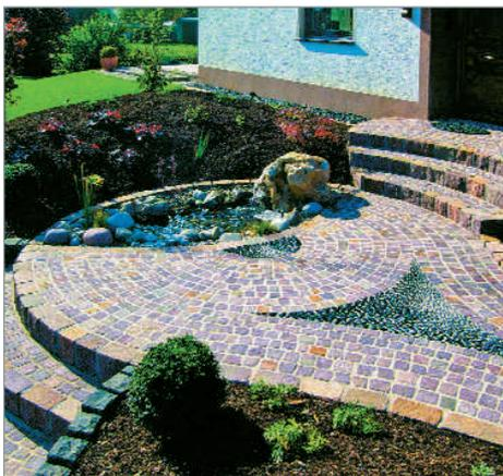
ее компонентов. При укладке необходимо следить за отсутствием растворимых загрязнений на брусчатке/ клинкере (пыли, патины и пр.), а также за тем, чтобы при необходимости водопоглощающая способность брусчатки/ клинкера была ограничена посредством их предварительного увлажнения. Слишком гладкие изнаночные и боковые стороны (к примеру, пиленая брусчатка) следует очистить.
