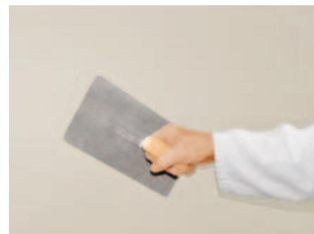
штукатурка наносится на основание методом набрызга, спустя 3 – 4 часа следует нанести верхний слой. Общая толщина штукатурного слоя должна составлять примерно 10 мм.
